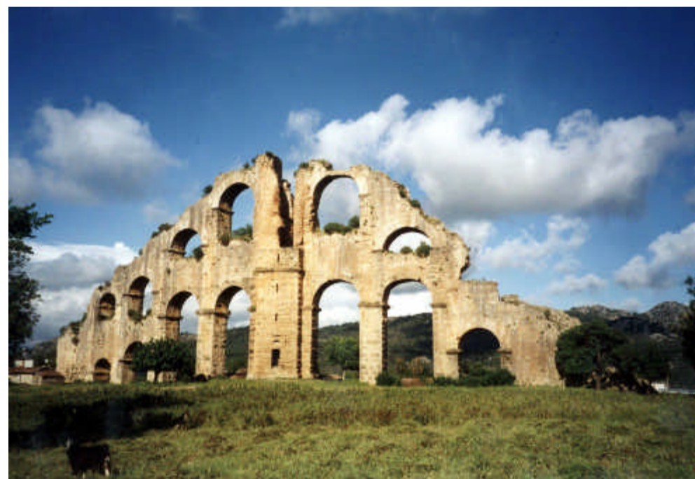
North hydraulic tower, present height 30 m Nördlicher hydraulischer Turm, noch vorhandene Höhe 30 m
